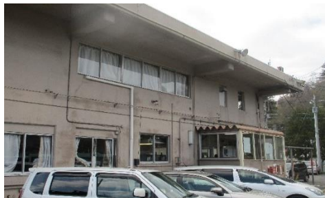
老朽化が進む川内営業所
